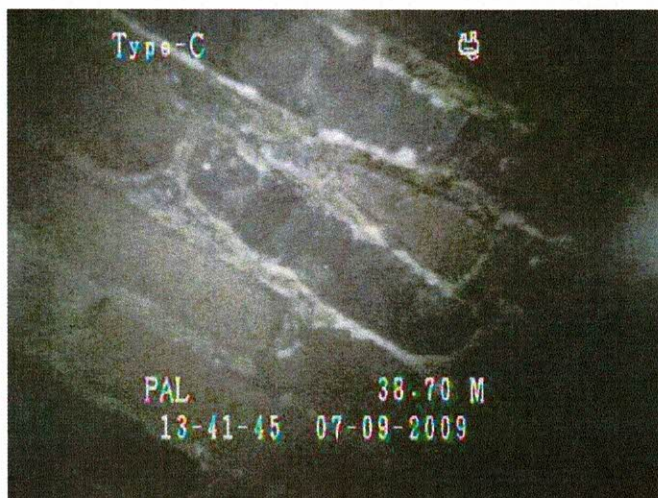
Rys. 1-2 Zmiana geometrii przekroju kanału na odcinku między studniami.
