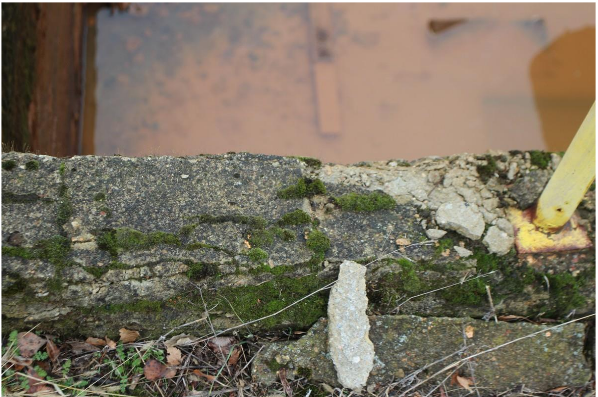
Fot.6. Uszkodzenia górnych krawędzi ścian spowodowane korozją mrozową
