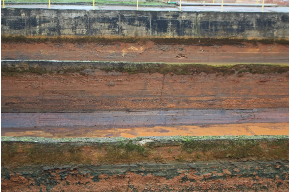
Fot.5. Pionowe zarysowania ścian
