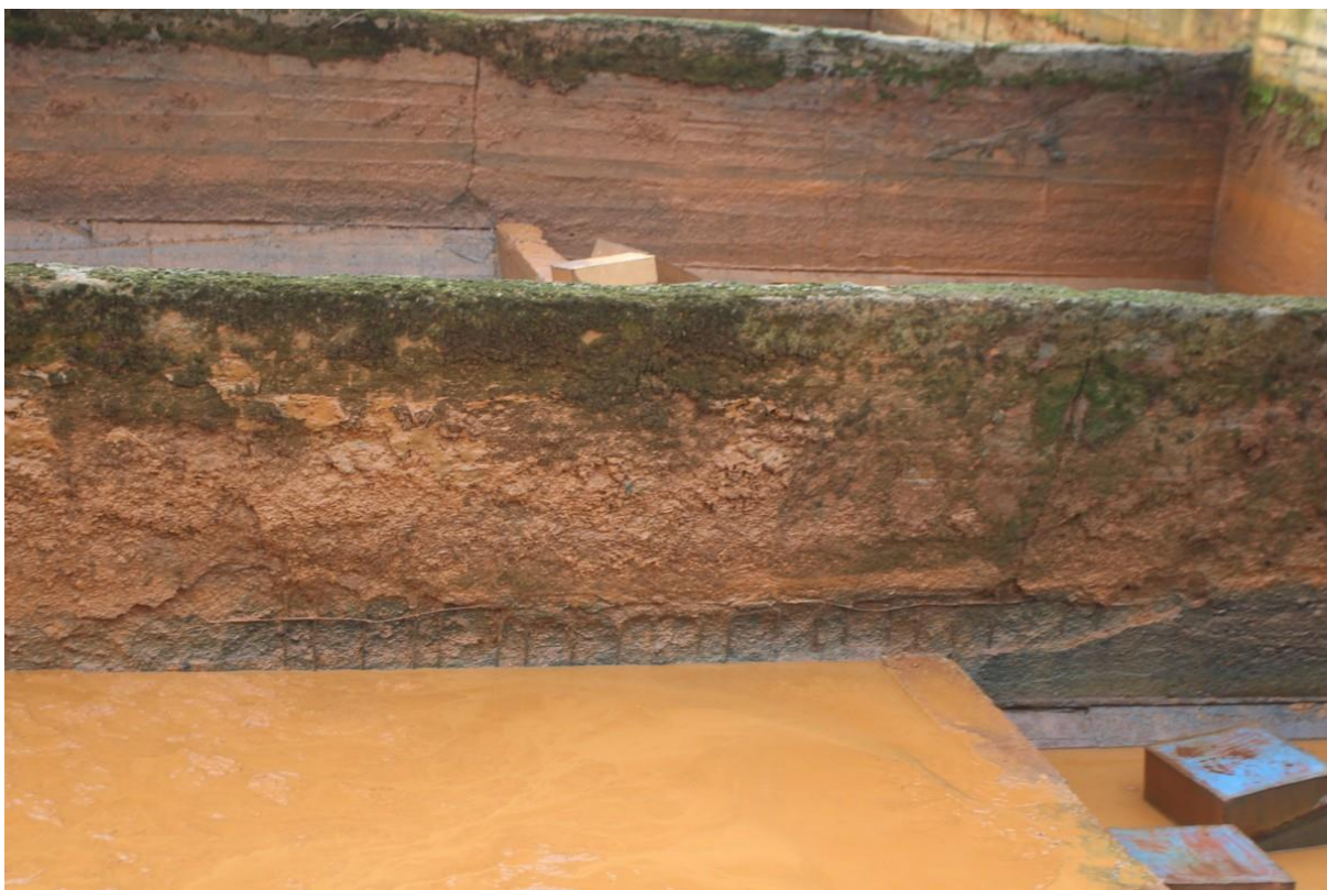
Fot.3. Widok uszkodzeń korozyjnych betonu i odsłoniętego zbrojenia, widoczne zarysowania ścian
