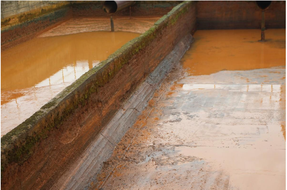
Fot.2. Widok wnętrza jednej z komór zbiornika, widoczna lokalnie korozja betonu
