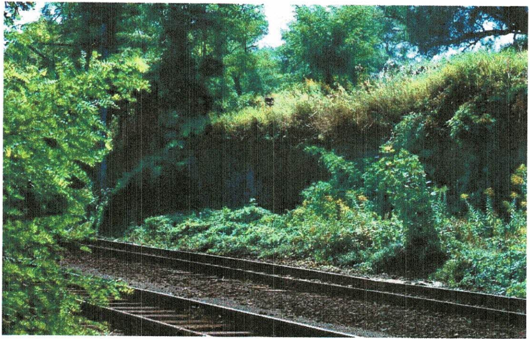
Rys. 4 Ściana oporowa przy torowisku kolejowym.
