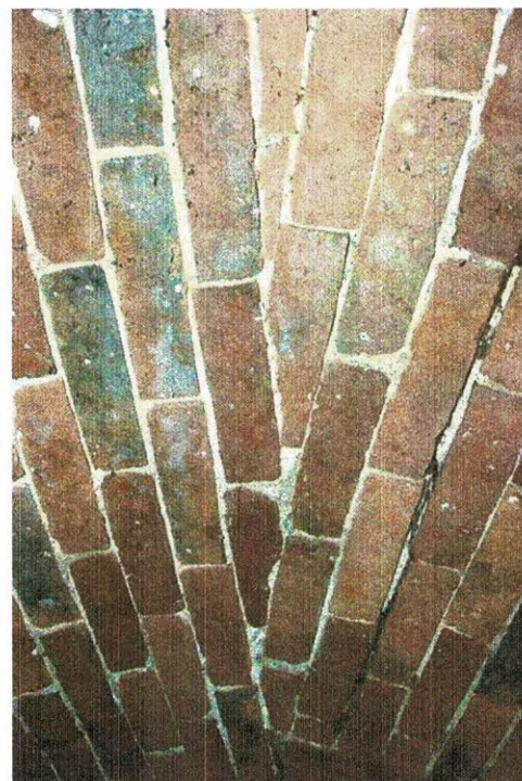
Rys. 1-2 Zmiana geometrii przekroju kanału na odcinku między studniami.
