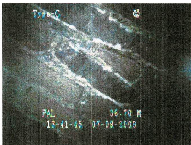
Rys. 1-2 Zmiana geometrii przekroju kanału na odcinku między studniami.
